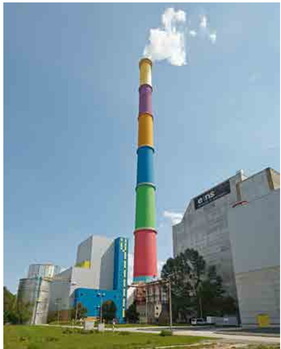
Der 302 Meter hohe Schornstein des Chemnitzer Heizkraftwerk ist dank des französischen Künstlers Daniel Buren zu einem farbigen, weit sichtbaren Zeichen für das Unternehmen eins gewachsen.
