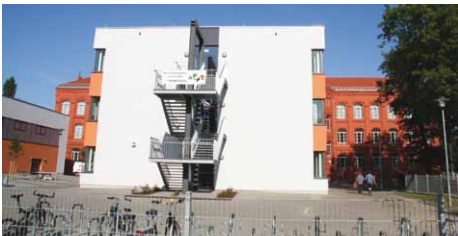
Das Werner-von-Siemens-Gymnasium nach erfolgreicher Sanierung. Neu errichtet wurden die Sporthalle, links im Bild, und der Anbau im Vordergrund.
